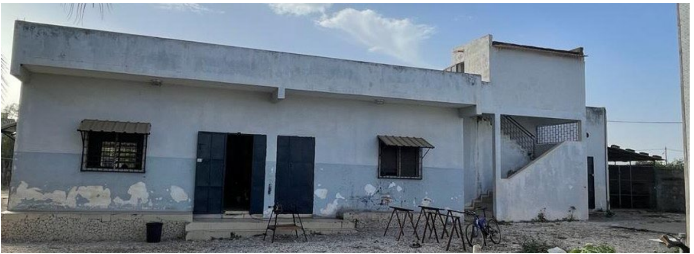
Unser Ausbildungsgebäude mit Schreiner- Metall- und Schusterwerkstatt von hinten
