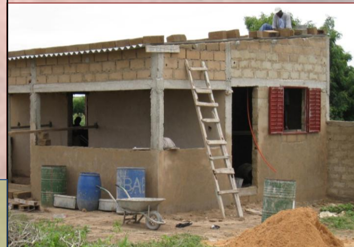
Baumateriallager, später wird es eine der Unterkünfte.
